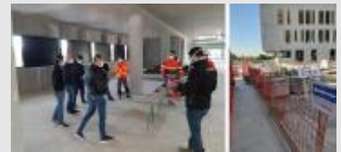
Sunset à Rennes (35) est un des premiers chantiers à avoir repris mi-avril dernier © Groupe Legendre
