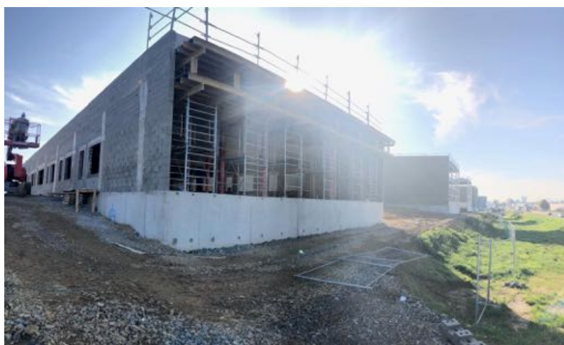
Bâtiment Comptoir de Bretagne en cours de construction. La livraison est prévue courant du 1 er trimestre 2021.
