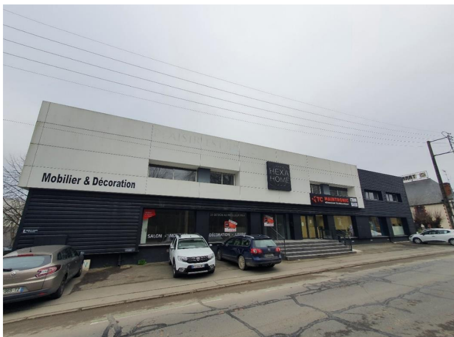
Bureaux et centre de formation / Boulevard de la Robiquette - Saint-Grégoire
