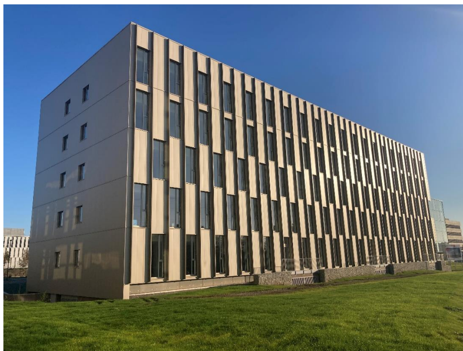
Immeuble de bureaux SOLARIS, ZAC Atalante Champeaux à Rennes.
